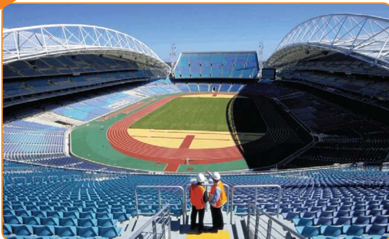
Figura 1: Estádio em concreto protendido, Sidnei, Austrália
