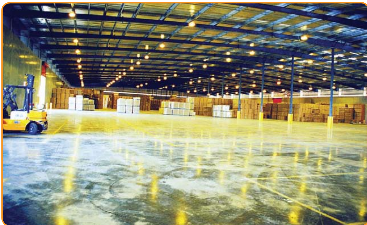
Figura 5: Piso protendido em Victoria, Austrália
